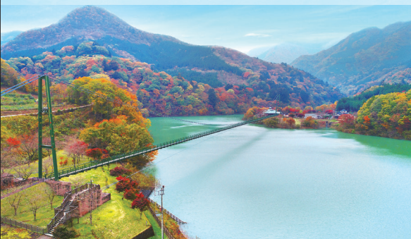
もみじ谷大吊橋
