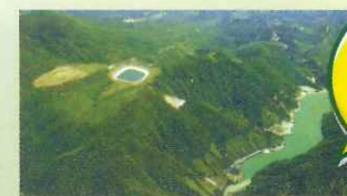
沼原調整池と発電所
